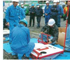
▲備蓄用仮設トイレの組み立て訓練も実施した。
